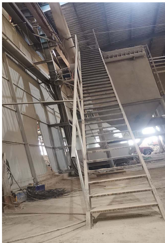
排气筒采样梯
