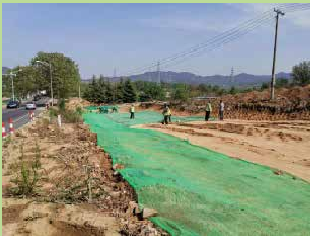
施工现场裸土遮盖
