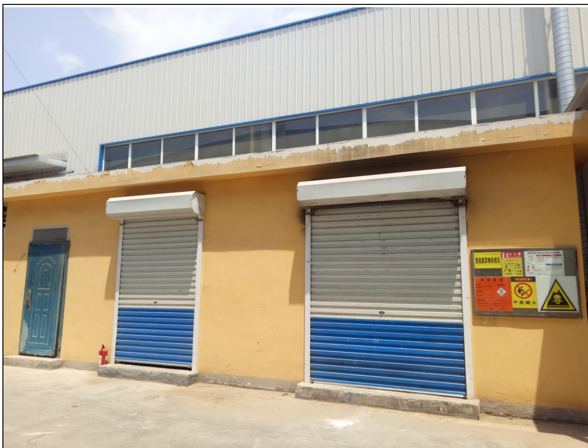
危废暂存间外部
