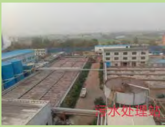
污水处理站（生化部分）
