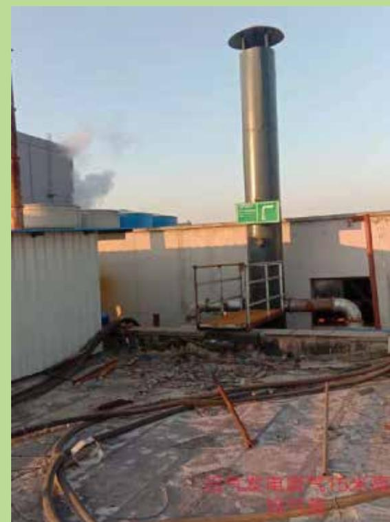
沼气发电废气 15 米高排气筒
