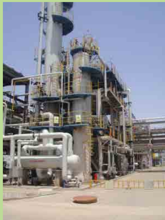
SHU 进料缓冲罐
