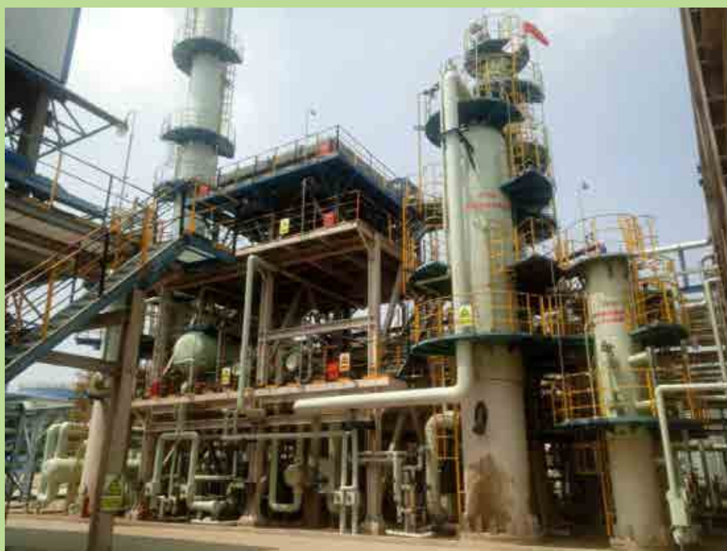
项目主体工程全景图
