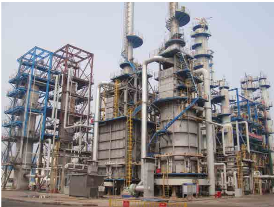
项目主体工程全景图
