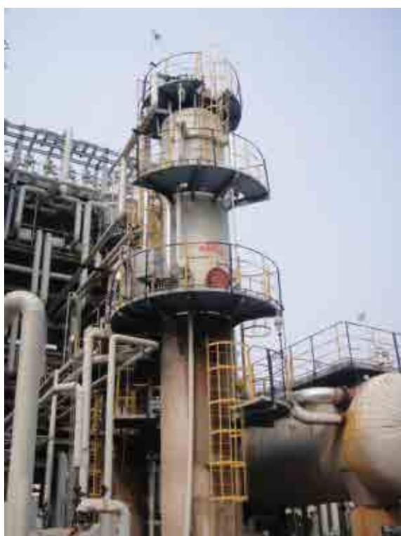
低压贫液缓冲罐
