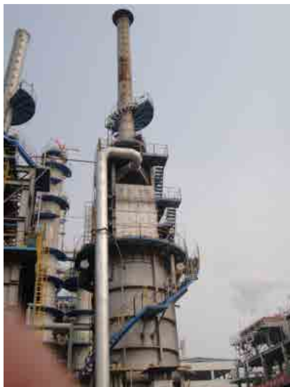
加氢装置主分馏塔底重沸炉 50m 高排气筒
