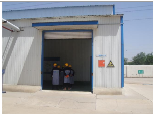
危险废物贮存（处置）场所环保图形标志
