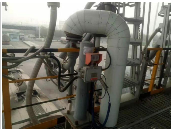
装车泵与装车设施相连，管道与料筒相连
