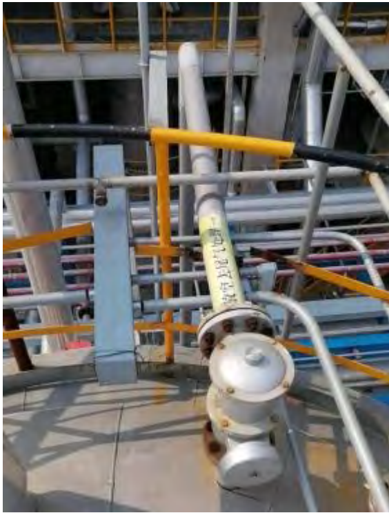
装置区废气收集
