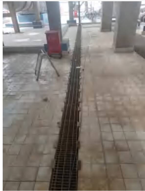
装置区导流槽
