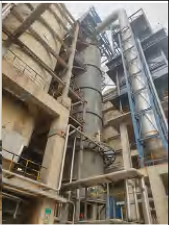
碱液洗涤脱硫塔
